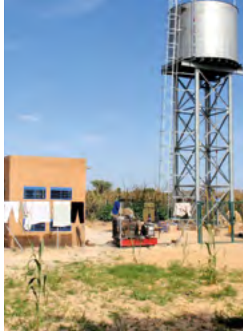
Groupe électrogène et château d'eau de Maïguizawa. Avec une consommation de 20 à 28 litres/jour/habitant, la viabilité des services est améliorée et l'épargne dédiée au renouvellement des équipements et aux extensions de réseau augmente.
