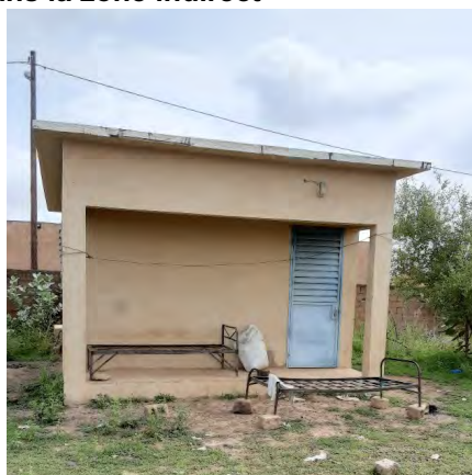
Photo 16. Zone d'influence directe (logement du conducteur du forage)
