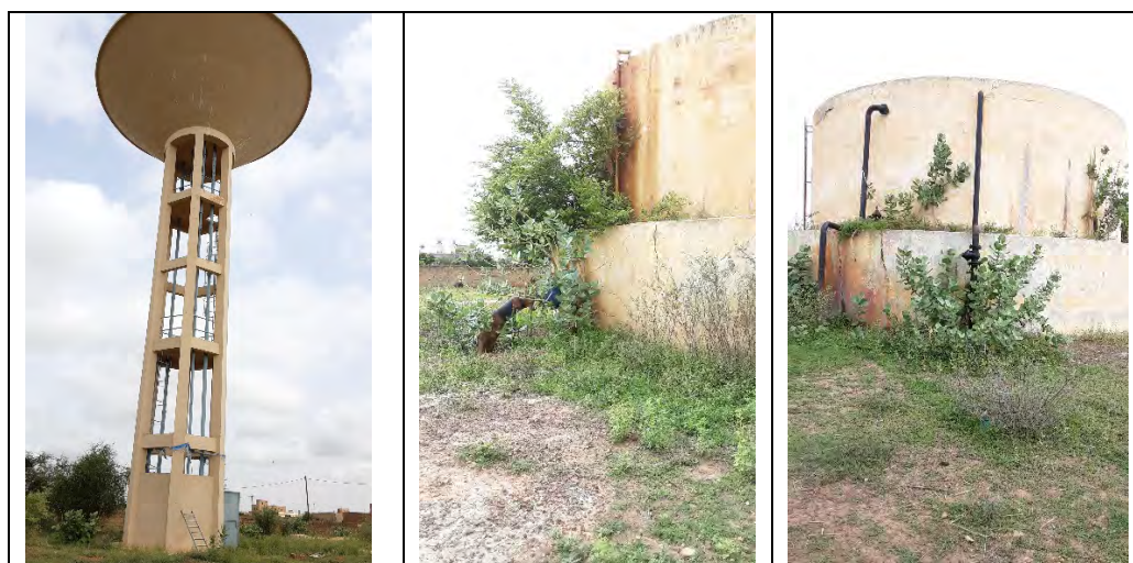
Photo 10 : ouvrages d'accès à l'eau potable dans la zone restreinte
