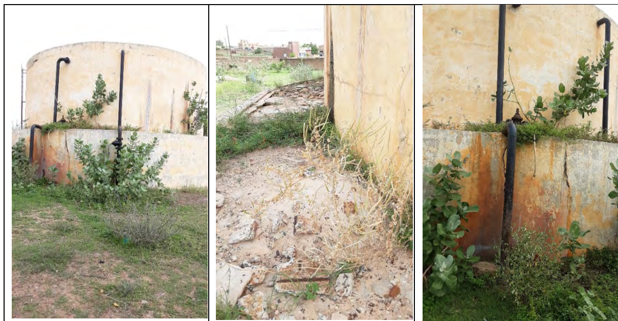
Photo 11 : Etat actuel du réservoir au Sol
