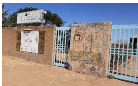
Poste de santé longé par le tuyau DN 90
