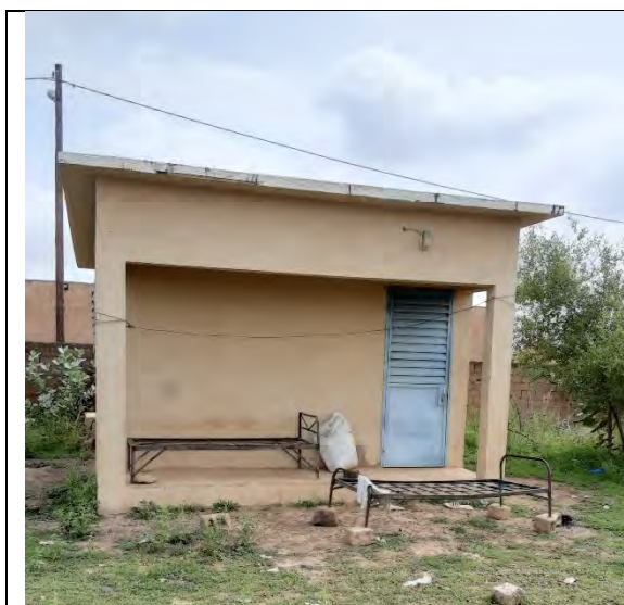
Photo 8 : logement du conducteur du forage
