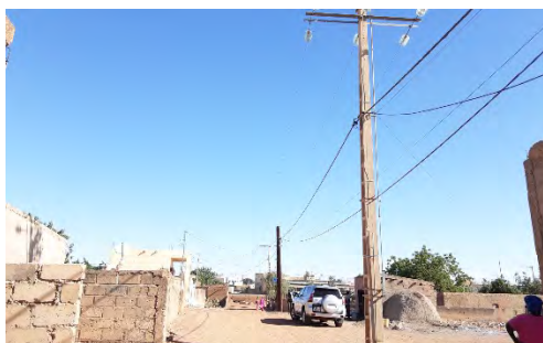
photo 20. Poteau électrique à la limite de l'emprise
