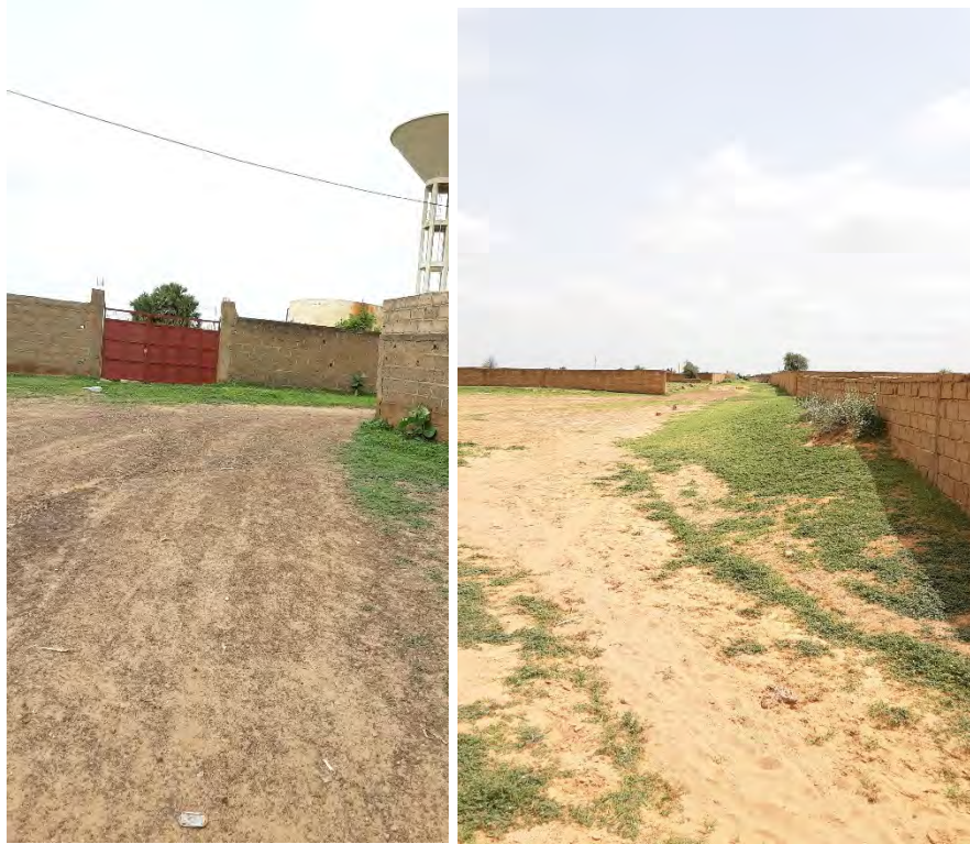
Photo 14. Voie d'accès au site
